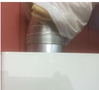
**Ennen letkun asentamista reikään, kiinnitä letkuun mukana toimitettu letkukiristin. Kiinnitä sitten venttiili ulkoseinään. Käytä aina silikonia tai muuta vastaavaa tiivistettä venttiilin tiivistämiseksi.**
