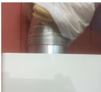
**För slangen genom hålet i väggen, fäst slangen till ventilen med medföljande slangklämma. Montera fast ventilen i ytterväggen. Tillför alltid silicon eller motsvarande tätningsmedel runt ventilen för att undvika vatteninträngning i väggen.**
