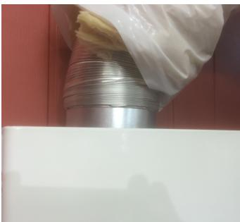
**Før slangen gjennom hullet i veggen, fest slangen til ventilen med medfølgende slangeklemme. Sett så fast ventilen i ytterveggen. Påfør alltid silicon eller tilsvarende tettemiddel rundt ventilen for å unngå vanninntregning i veggen.**
