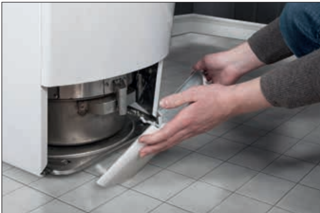
Avaa etuosan luukku - luukku avataan painamalla ensin sitä alaspäin ja sitten vetämällä ylös päin.
